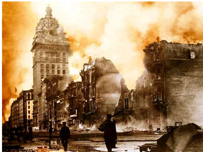
Slika 2: Požar v San Franciscu (foto: [10]).
