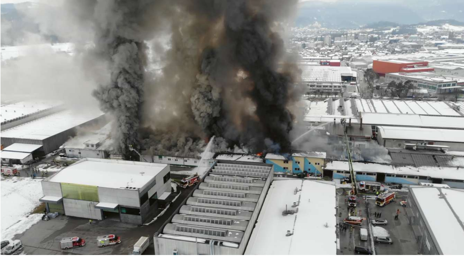
Slika 3: Razvoj požara na južni strani industrijskega objekta
