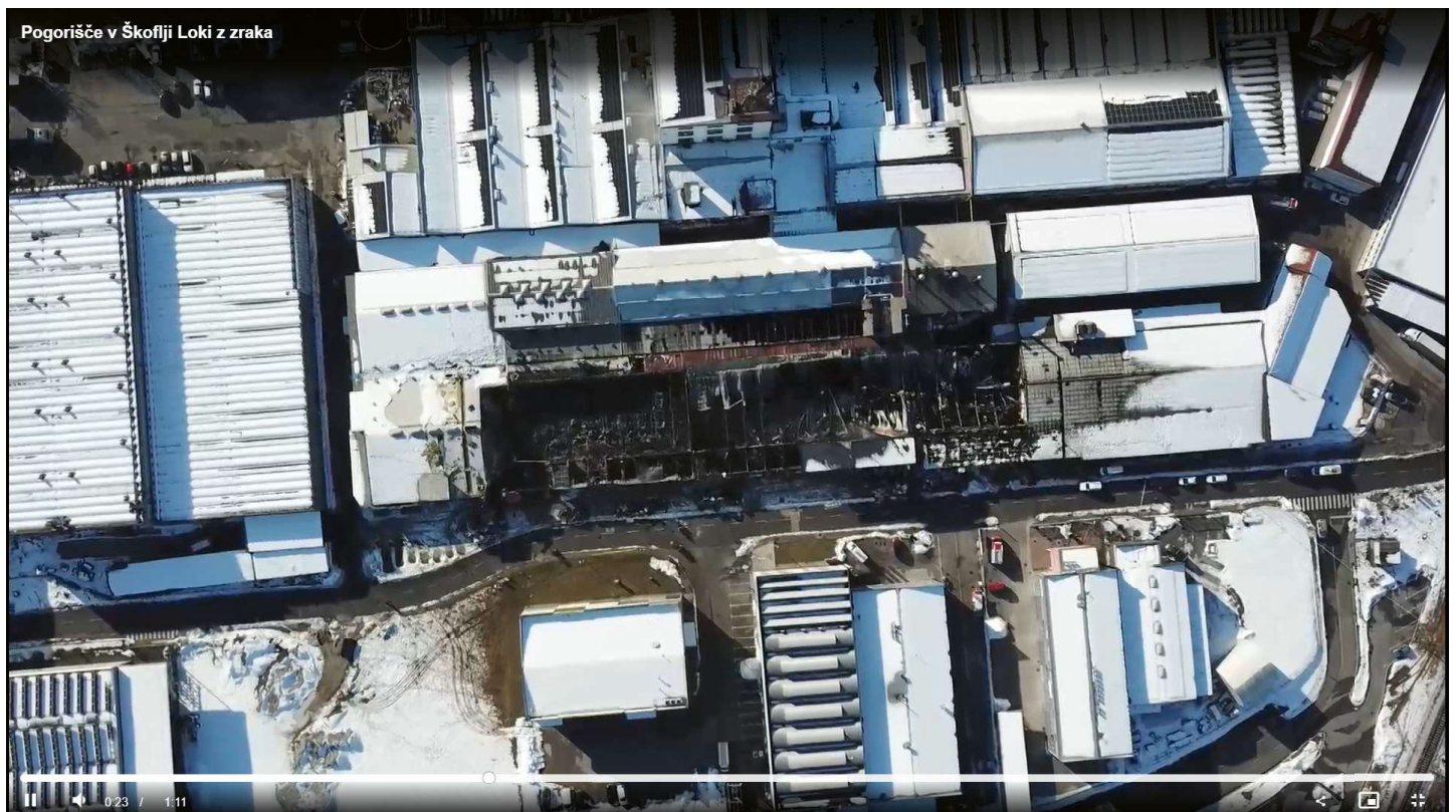
Slika 4: Posnetek industrijskega objekta po požaru iz zraka (vir: POPTV)
