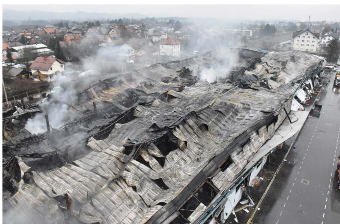
Objekt po požaru – od zgoraj (foto: Milan Hajduković)
