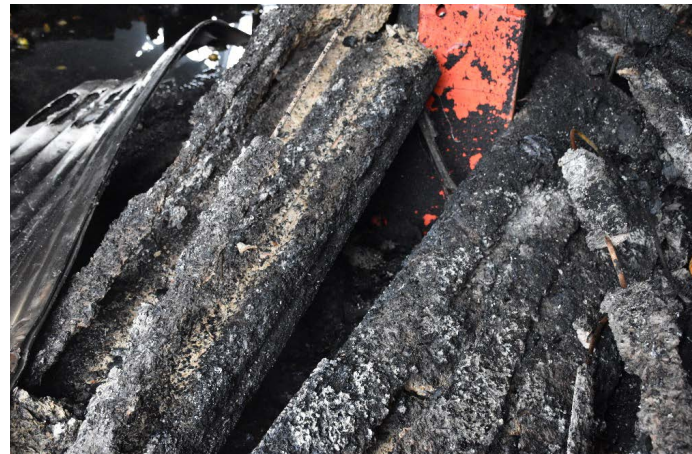
Odpadla armirana heraklit plošča stropa (foto: Milan Hajduković)
